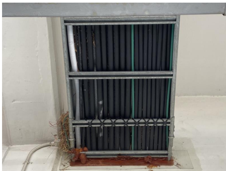
รูปที่ 18 : แสดงการติดตั้ง CABLE แต่ละเส้นใน CABLE LADDER วางเป็นแนวนอนขนานกัน
