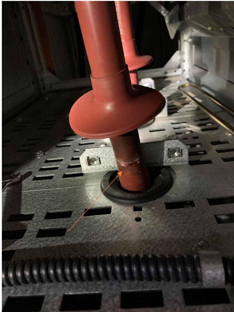
รูปที่ 1 ติดตั้ง Cable grand เหนือ Shielded
