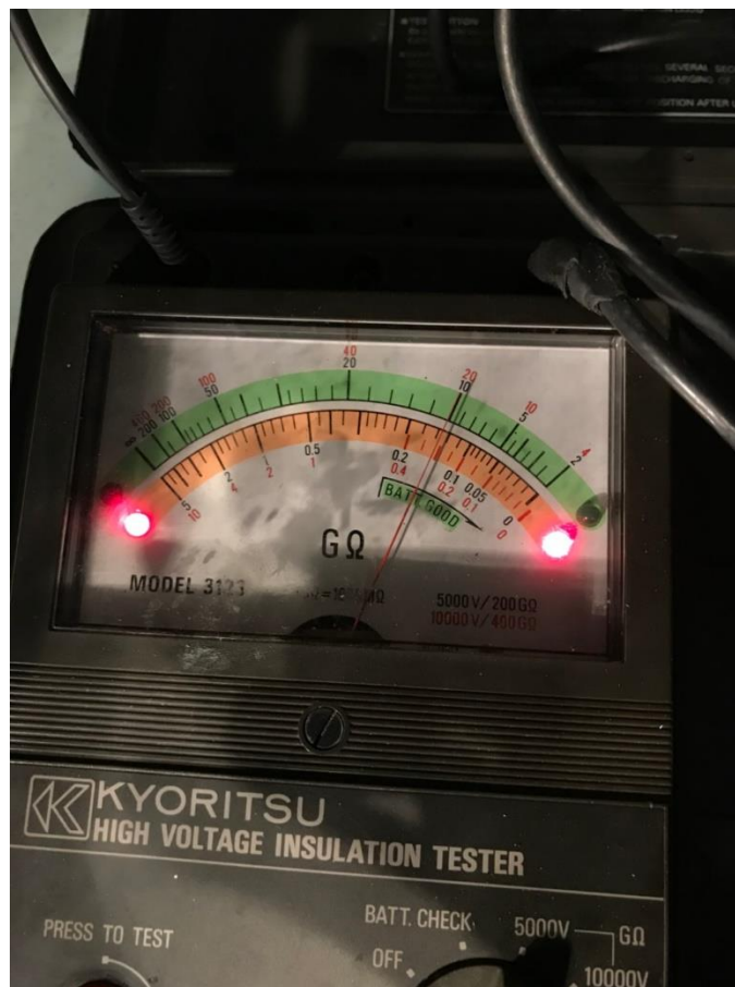
ภาพที่ 4 Insulation resistance ของTransformer ผลการทดสอบต่ำกว่ามาตรฐาน แก้ไขโดยการกรองน้ำมันหม้อแปลง
