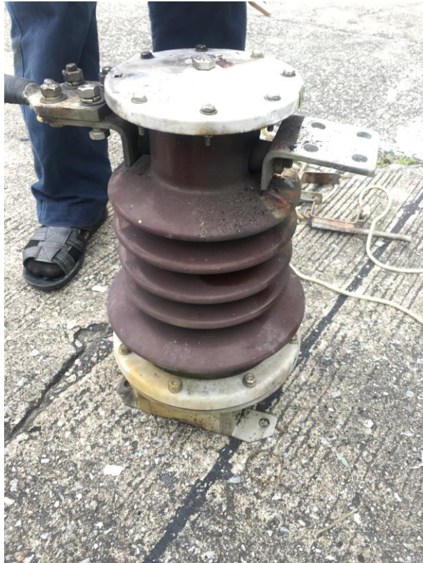
รูปที่ 16 CT ที่เสื่อมสภาพทำให้เกิด Fault
