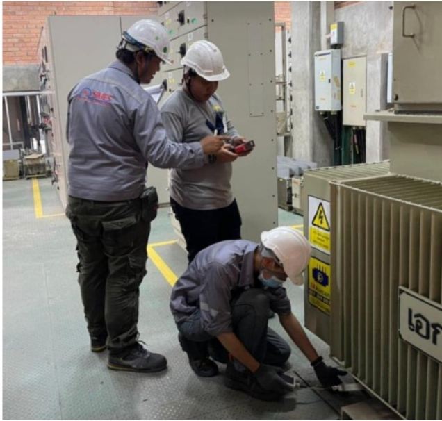
ภาพที่ 1 แสดงการตรวจวัดการเกิด Partial Discharge ในกรวดหม้อแปลง ด้วยอุปกรณ์ ตรวจวัดการเกิด Partial Discharge ชนิด HFCT
