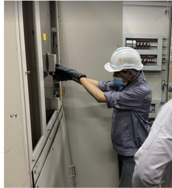
ภาพที่ 2 แสดงการตรวจวัดการเกิด Partial Discharge ภายในตู้ MDB ด้วยอุปกรณ์ตรวจวัดการเกิด Partial Discharge ชนิด UHF
