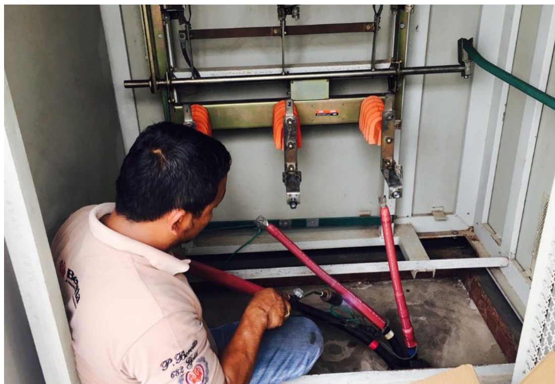
SOLUTION : ทำการเปลี่ยน 22KV TERMINATOR AT LOAD BREAK PANEL ทั้งหมดยกเว้น INCOMING
