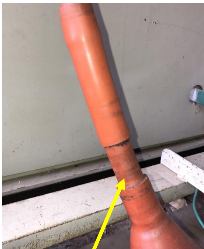
สภาพเนื้องานของ 22 KV TERMINATOR มีรอยชำรุด
