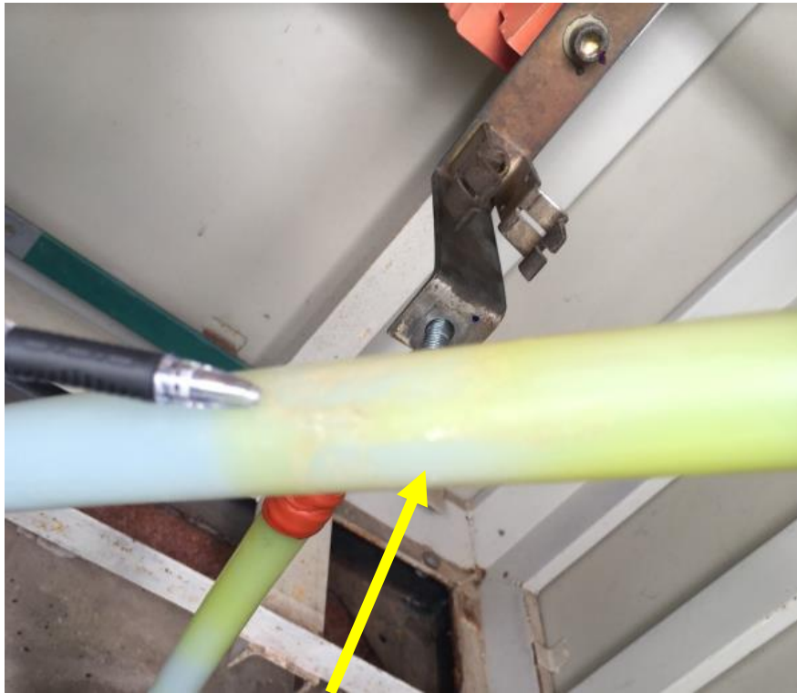
สภาพเนื้ฉนวนของ CABLE มีรอยชำรุด เมื่อนำ EXISTING TERMINATOR ออก
