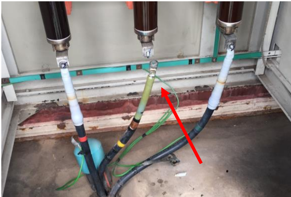
สภาพเนือฉนวนของ CABLE มีรอยชำรุด เมื่อนำ EXISTING TERMINATOR ออก
