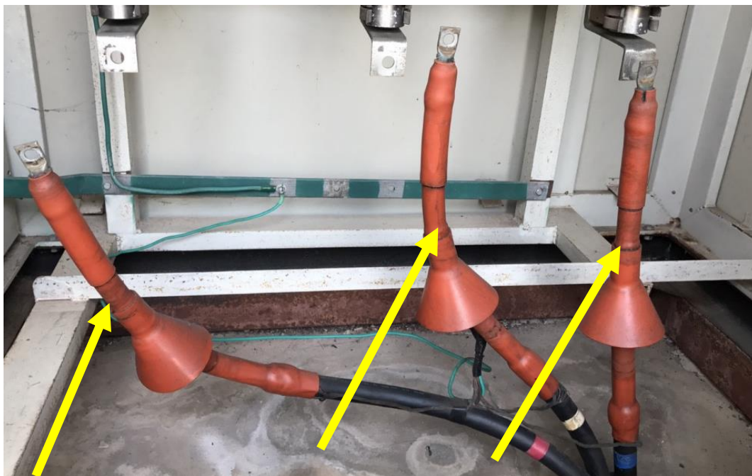
สภาพเนื้องานของ 22 KV TERMINATOR มีรอยชำรุด
