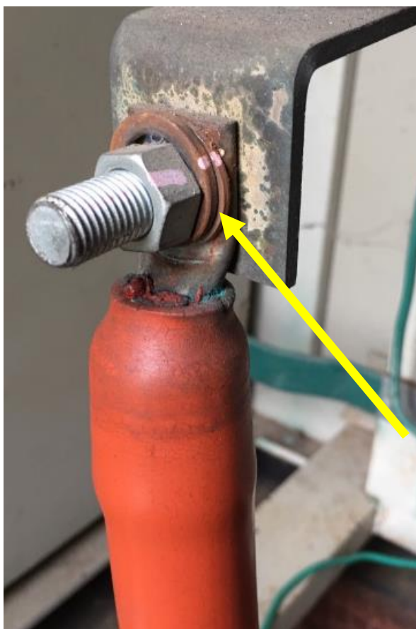
เกิดสนิมที่บริเวณแหวนและหางปลาของหัวเคเบิล เนื่องจาก มี PARTIAL DISCHARGE สูง
