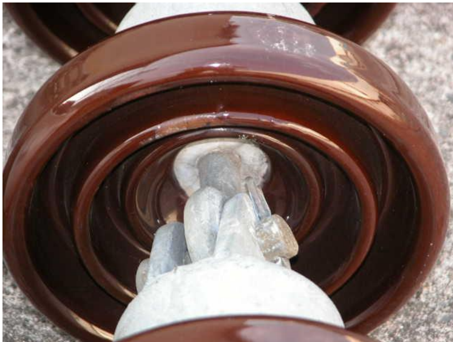
รูปที่ 3 ผลของการเกิด Partial discharge ที่ลู่กถ้วย (Insulator)
