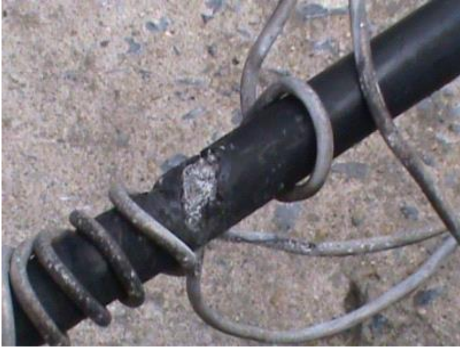
รูปที่ 2 ผลของการเกิด Partial discharge ที่สาย Cable
