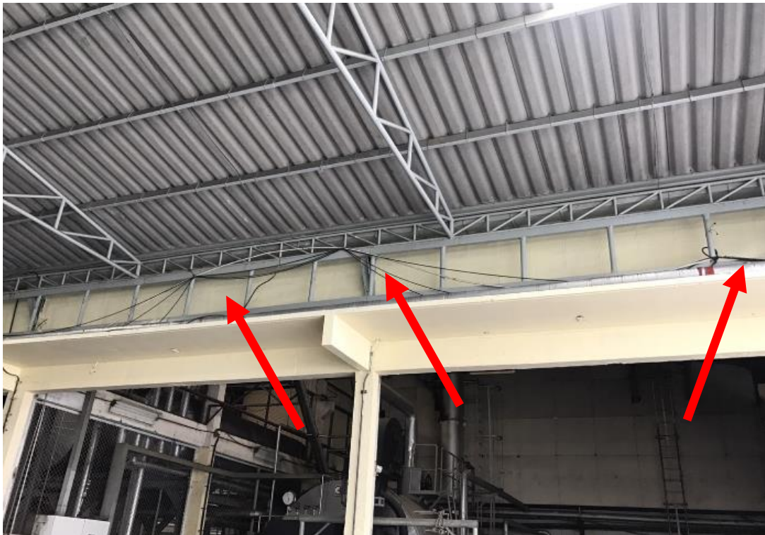
รูปที่ 18 การเดินสายไฟบริเวณหน้าหน้าห้องน้ำ
