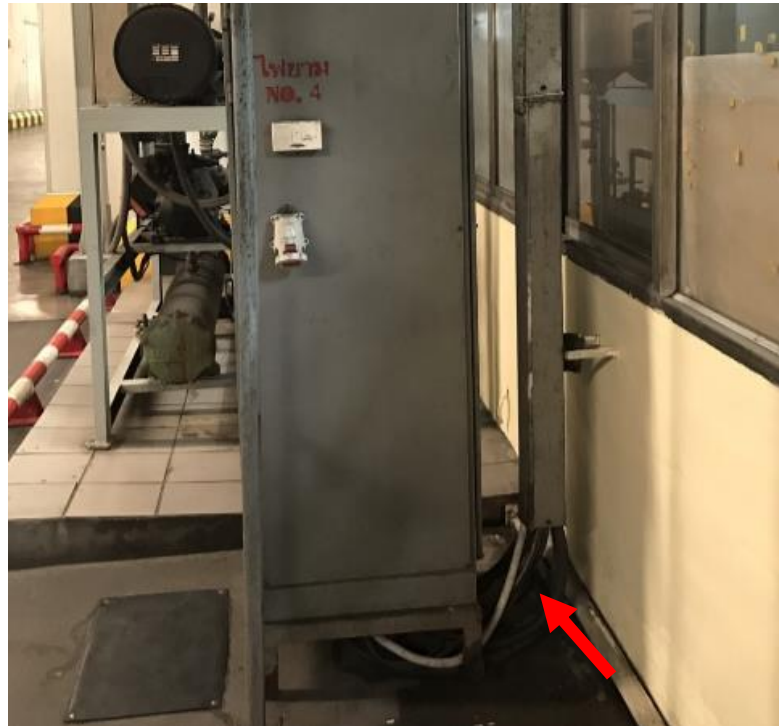
รูปที่ 21 ตู้ไฟฟ้าที่บริเวณพื้นมีน้ำทิ้งจากเครื่องปรับอากาศ
