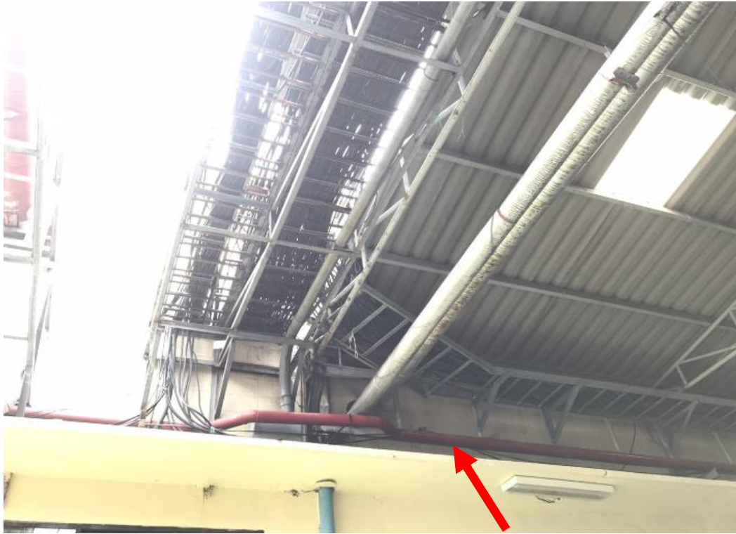
รูปที่ 17 การเดินสายไฟบริเวณหน้าหน้าห้องน้ำ
