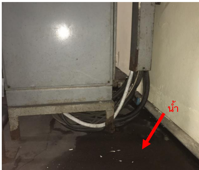
รูปที่ 22 สายไฟที่วางอยู่กับพื้นที่มีน้ำทิ้งจากเครื่องปรับอากาศ
