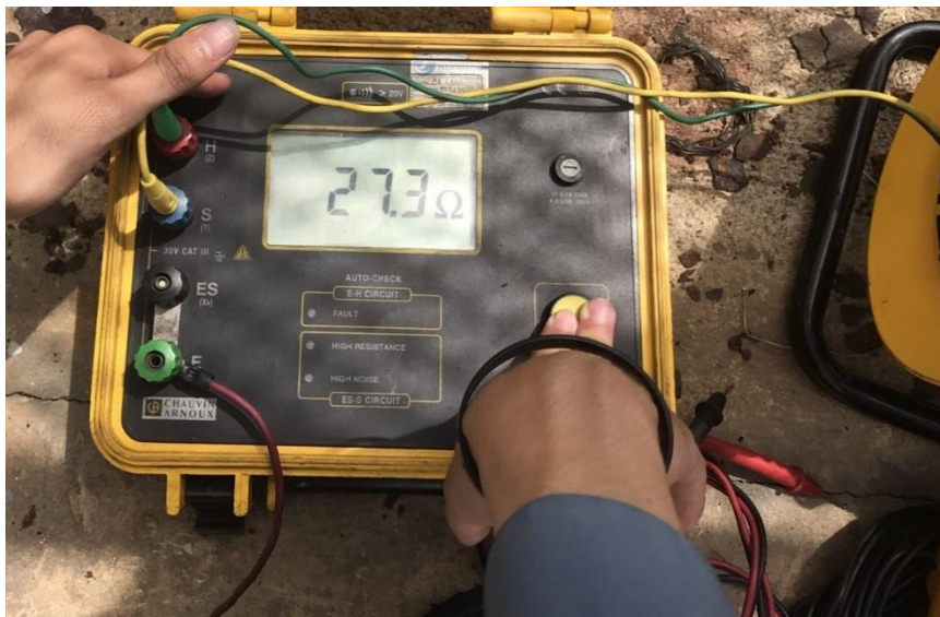
รูปที่ 8 ค่า Ground resistance TR 800 kVA ค่า 27.3 \Omega
