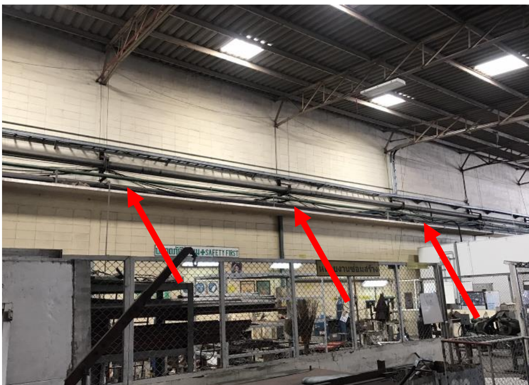
รูปที่ 16 การเดินสายไฟบริเวณหน้าซ้อปเครื่องกล
