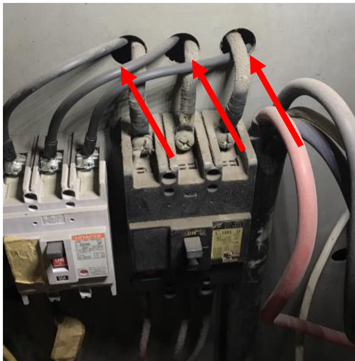
รูปที่ 20 รูสำหรับสายไฟเข้าและออกในตู้ไฟฟ้าไม่มียางรองขอบ
