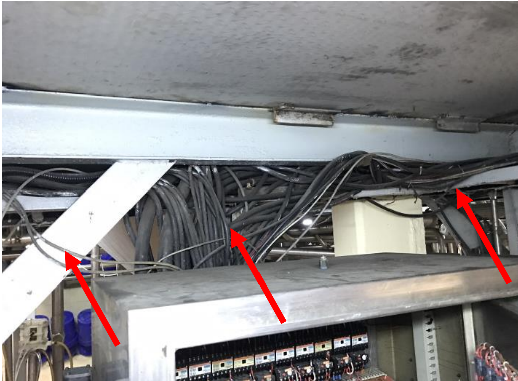
รูปที่ 15 สายไฟที่เข้าและออกจากตู้ควบคุม
