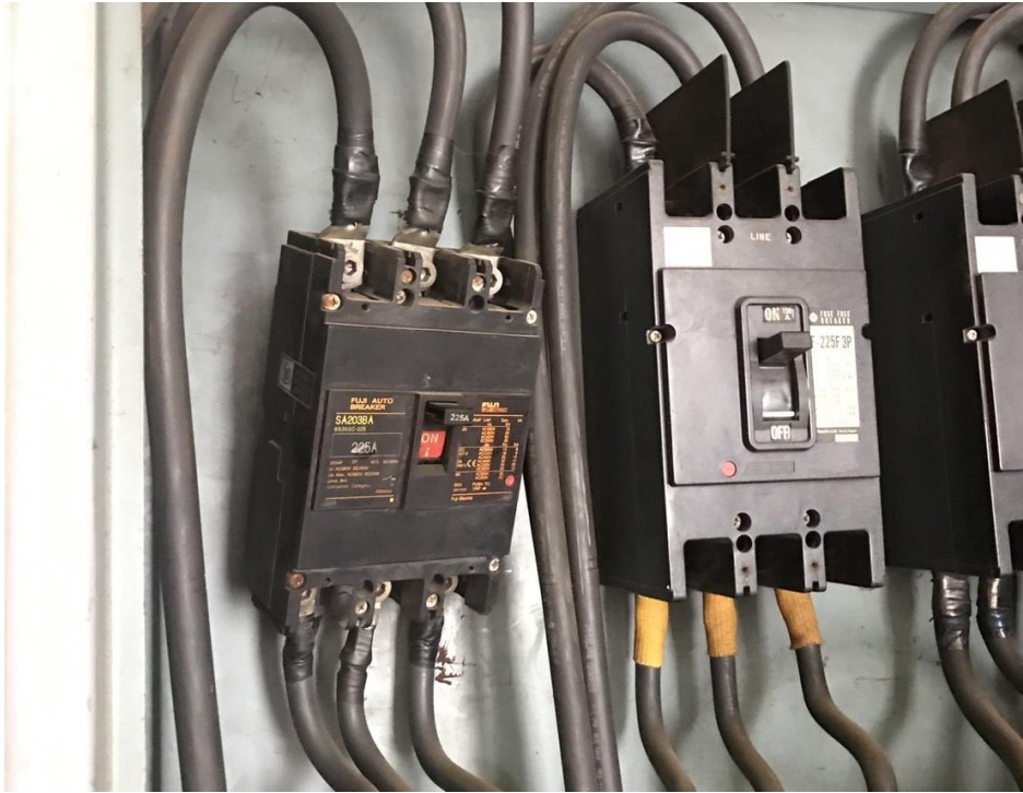
รูปที่ 25 เบรกเกอร์ไม่ได้ยึดติดกับโครงสร้างตู้
