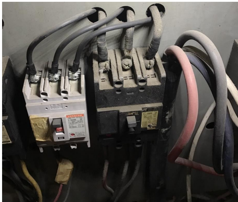
รูปที่ 28 สภาพฝุ่นที่จับบนเบรกเกอร์
