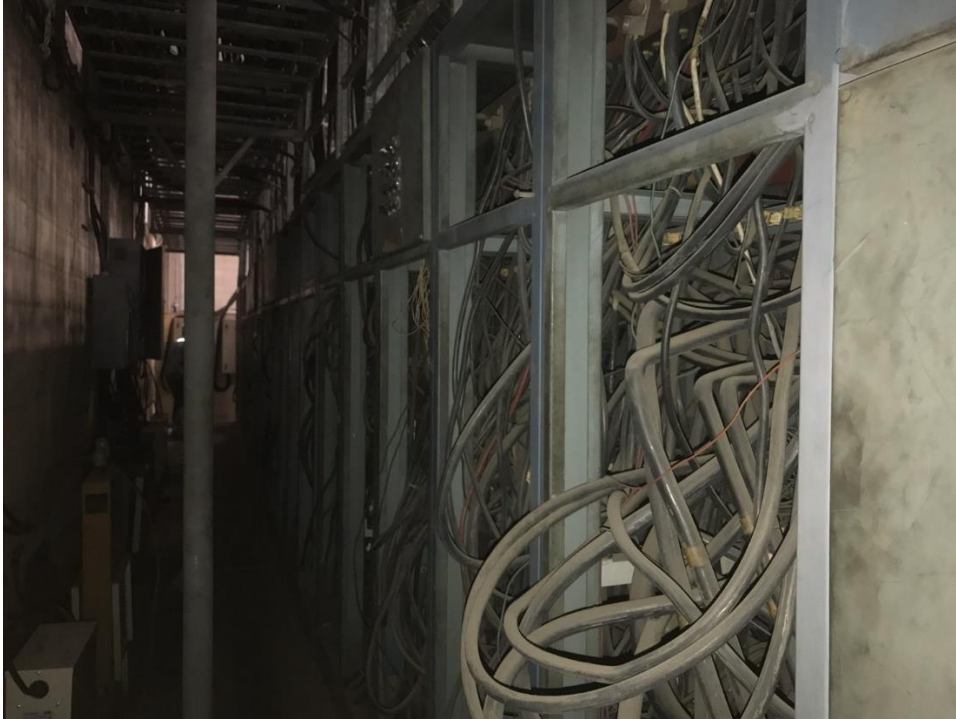
รูปที่ 23 สภาพด้านหลังตู้ MDB ของห้องไฟฟ้า 1
