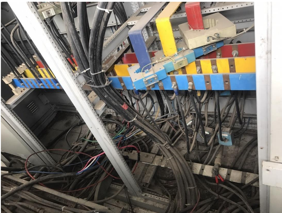
รูปที่ 24 สภาพด้านหลังตู้ MDB ของห้องไฟฟ้า 4
