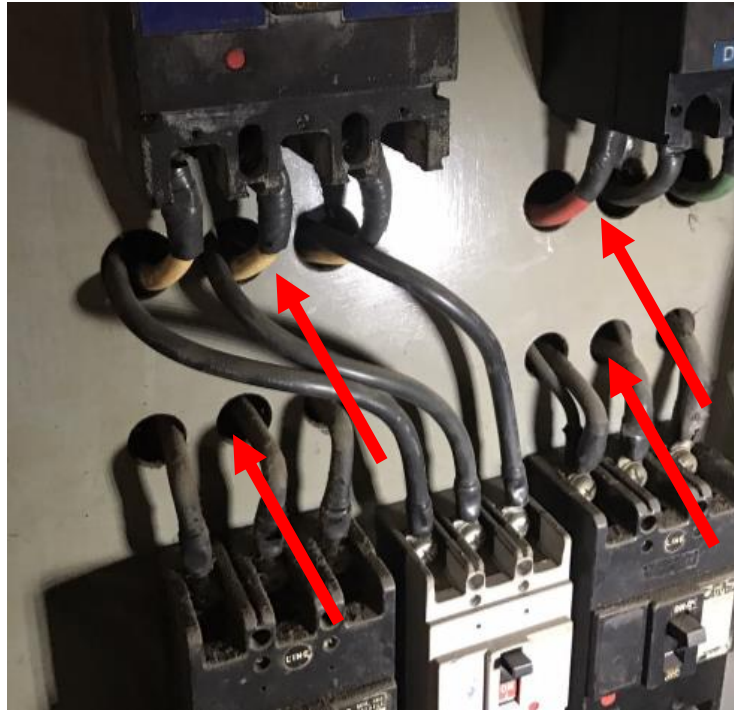
รูปที่ 19 รูสำหรับสายไฟเข้าและออกในตู้ไฟฟ้าไม่มียางรองขอบ
