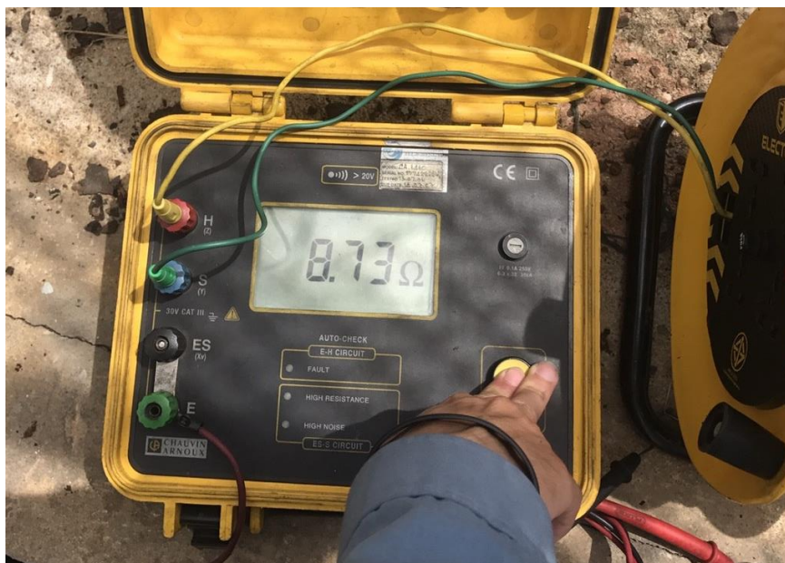
รูปที่ 9 ค่า Ground resistance TR 500 kVA ค่า 8.73 \Omega
