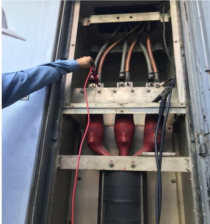
รูปที่ 5 : แสดงการทดสอบวัดค่า INSULATION RESISTANCE POWER CABLE เฟส B
