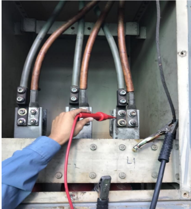
รูปที่ 3 : แสดงการทดสอบวัดค่า INSULATION RESISTANCE POWER CABLE เฟส R
